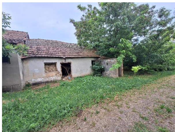
Zgrada br.2- pomoćna zgrada
